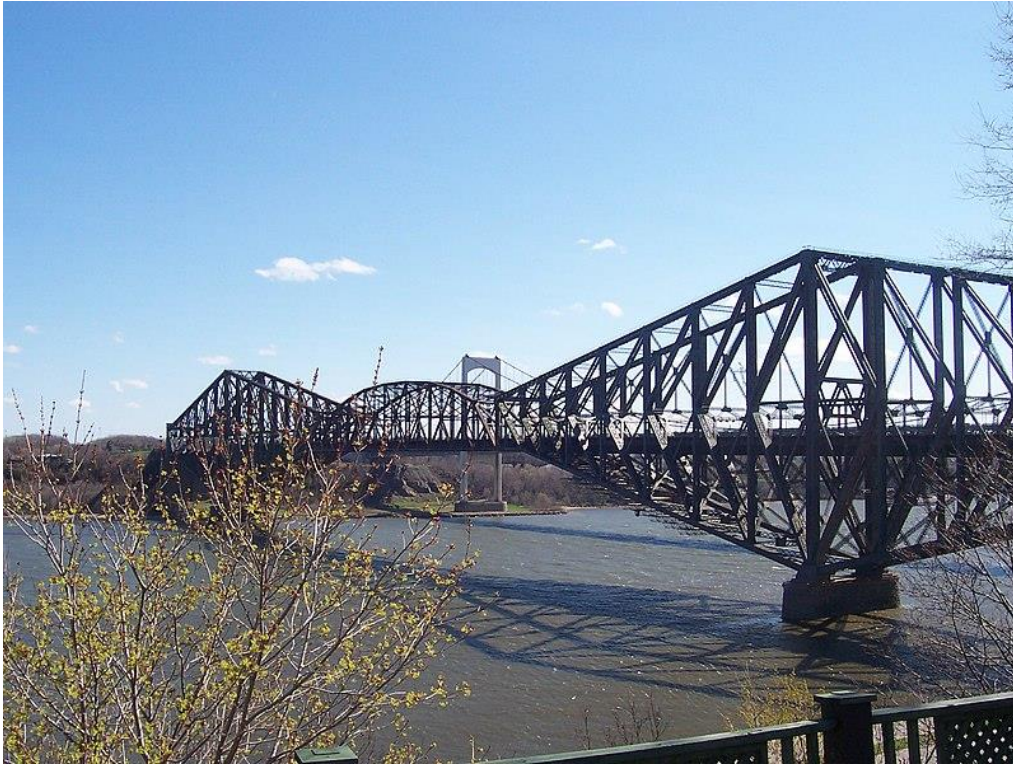
Slika 1 Savard, S. (2006). Pogled na Quebec Bridge iz Parc Aquarium du Québec (Quebec City, Quebec, Canada). Wikipedia. https://commons.wikimedia.org/wiki/File:Pont_de_Qu%C3%A9bec_vu_du_Parc_aquarium_du_Qu%C3%A9bec.JPG
